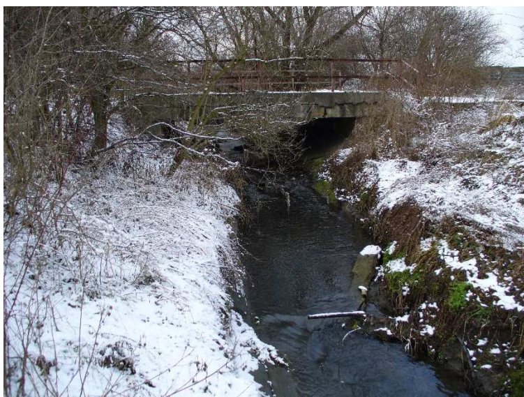
obr. 17 – úsek 07, pohled proti proudu na objekt č. 9 navržený k nahrazení lávkou
